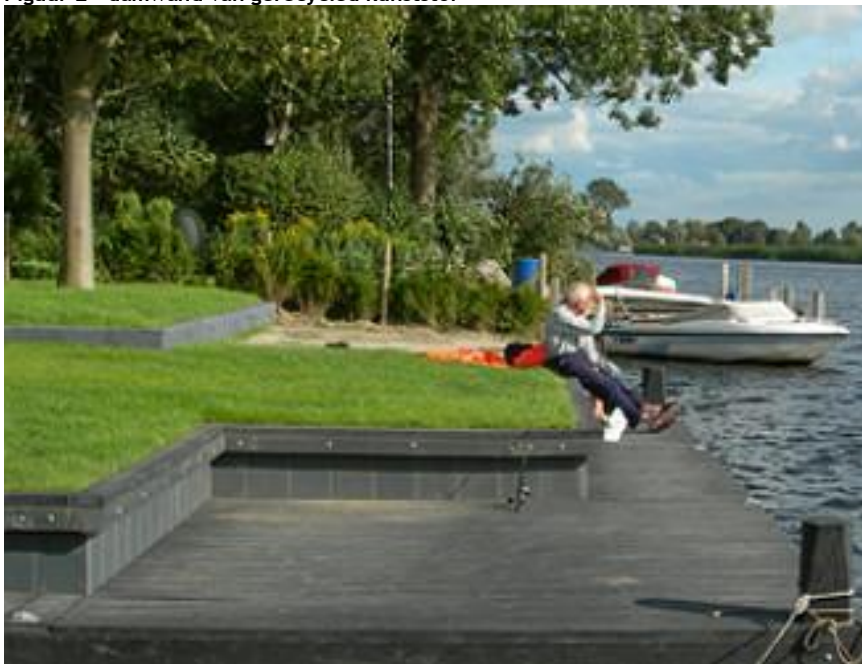
Figuur 2 - damwand van gerecycled kunststof
