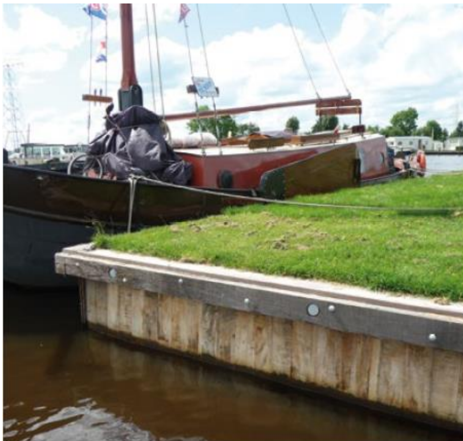
Figuur 2 - Damwand van Europees hardhout
