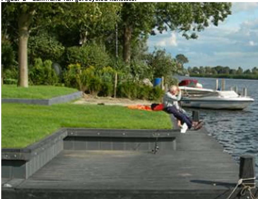
Figuur 2 - damwand van gerecycled kunststof
