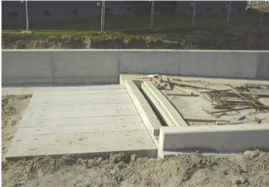
Figuur 3 - Stootplaat van beton
