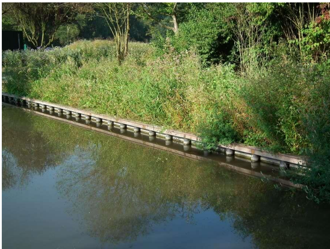
Figuur 2 - Beschoeiingselement van hout en gerecycled kunststof
