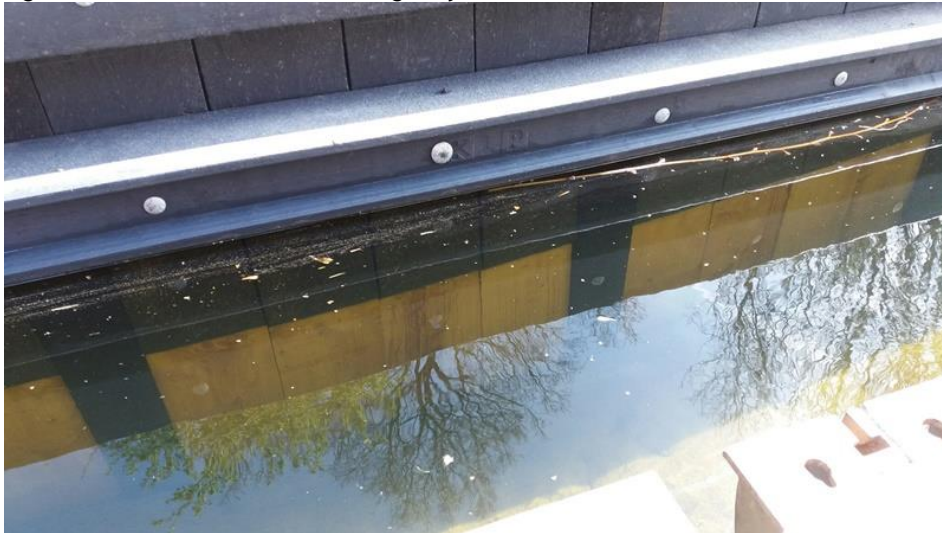
Figuur 2 - damwand van vurenhout en gerecycled kunststof
