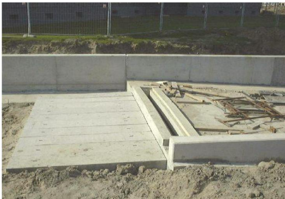
Figuur 3 - Stootplaat van beton
