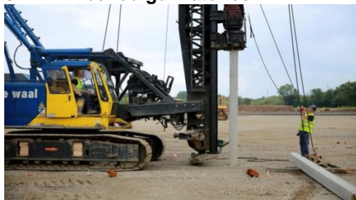
heistelling voor het heien van de palen
