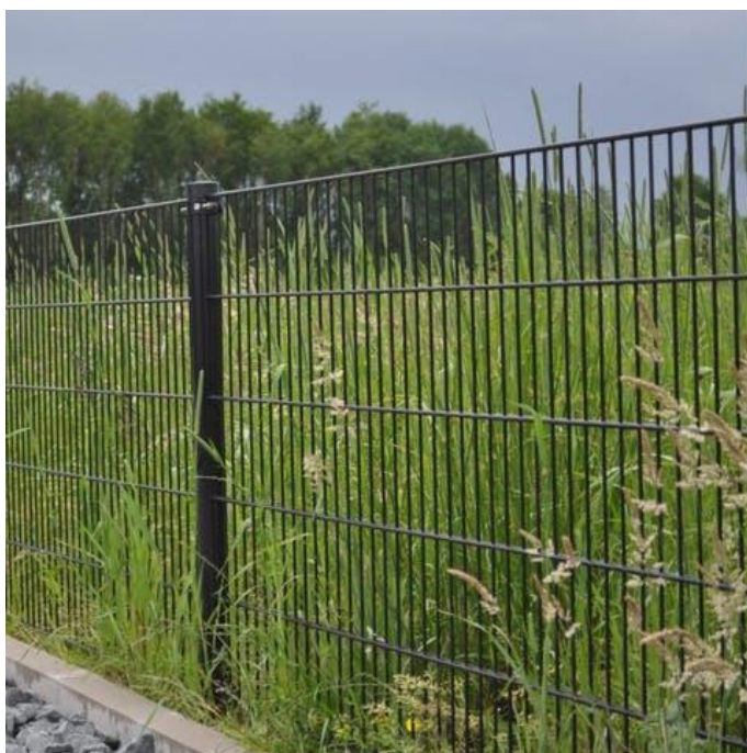
Figuur 3: Afbeelding staafmathekwerk
