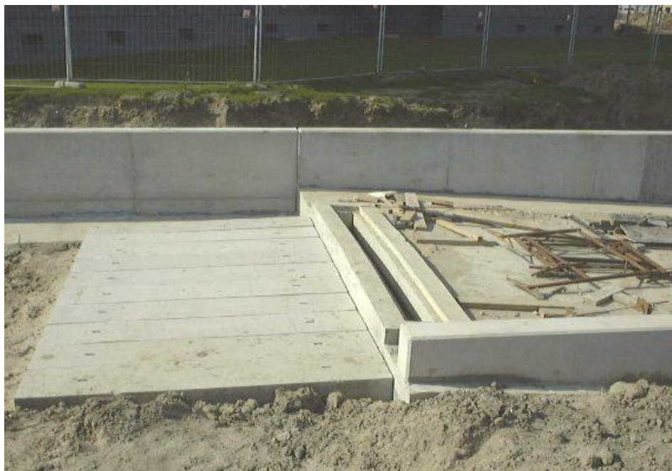
Figuur 3 - Stootplaat van beton
