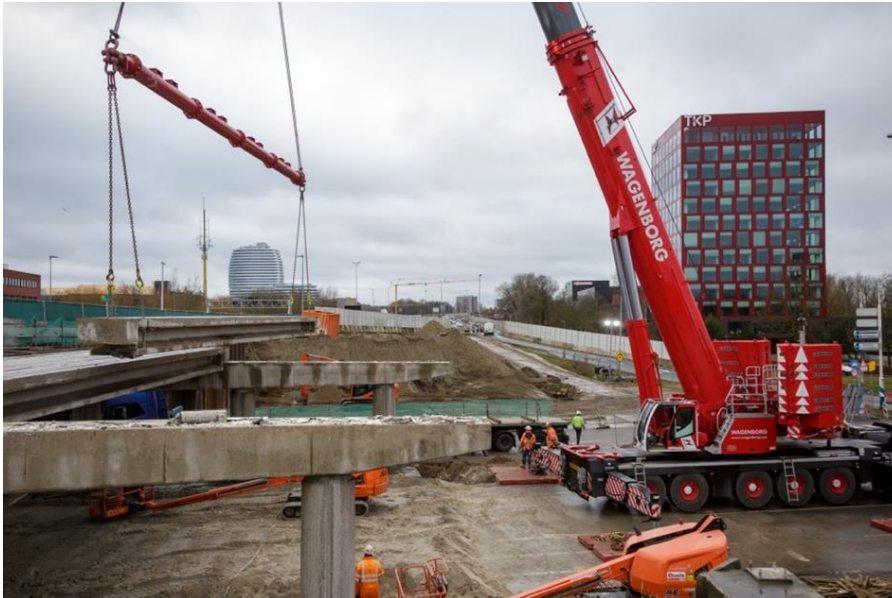
Circulaire viaducten Foto: RWS
