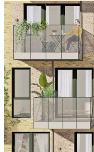
Door de oude balustradehekken tegen elkaar aan te lassen voldeden de hekken aan de huidige eisen. Foto Bo-Ex
