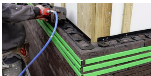
Afbeelding 7.1 Drooggestapeld metselwerk
