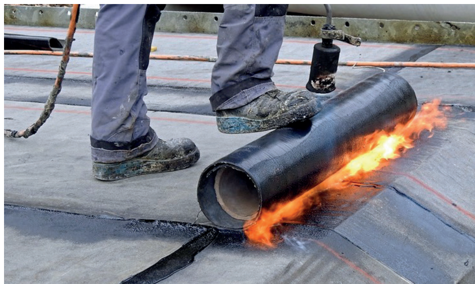
Figuur 78. aanleggen van bitumen
