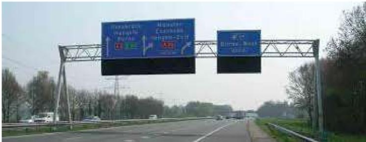
Figuur 5: bewegwijzeringsborden inclusief signaalgevers aan RWS portaal
