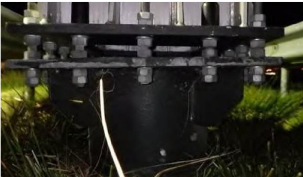
Figuur 10: detail fundering aluminium portaal
