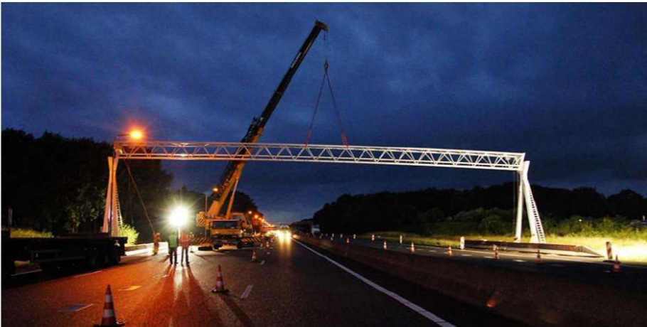
Figuur 9: montage ligger met kraan
