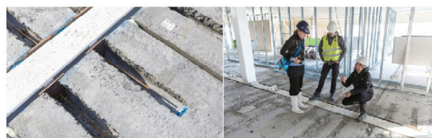
Figuur 21: Foto vloeropbouw (a) en type verbinding (b) Tijdelijke Rechtbank
